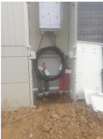
Obr. 1 Ilustračné prevedenie Skrine optickej nadzemnej počas montáže
